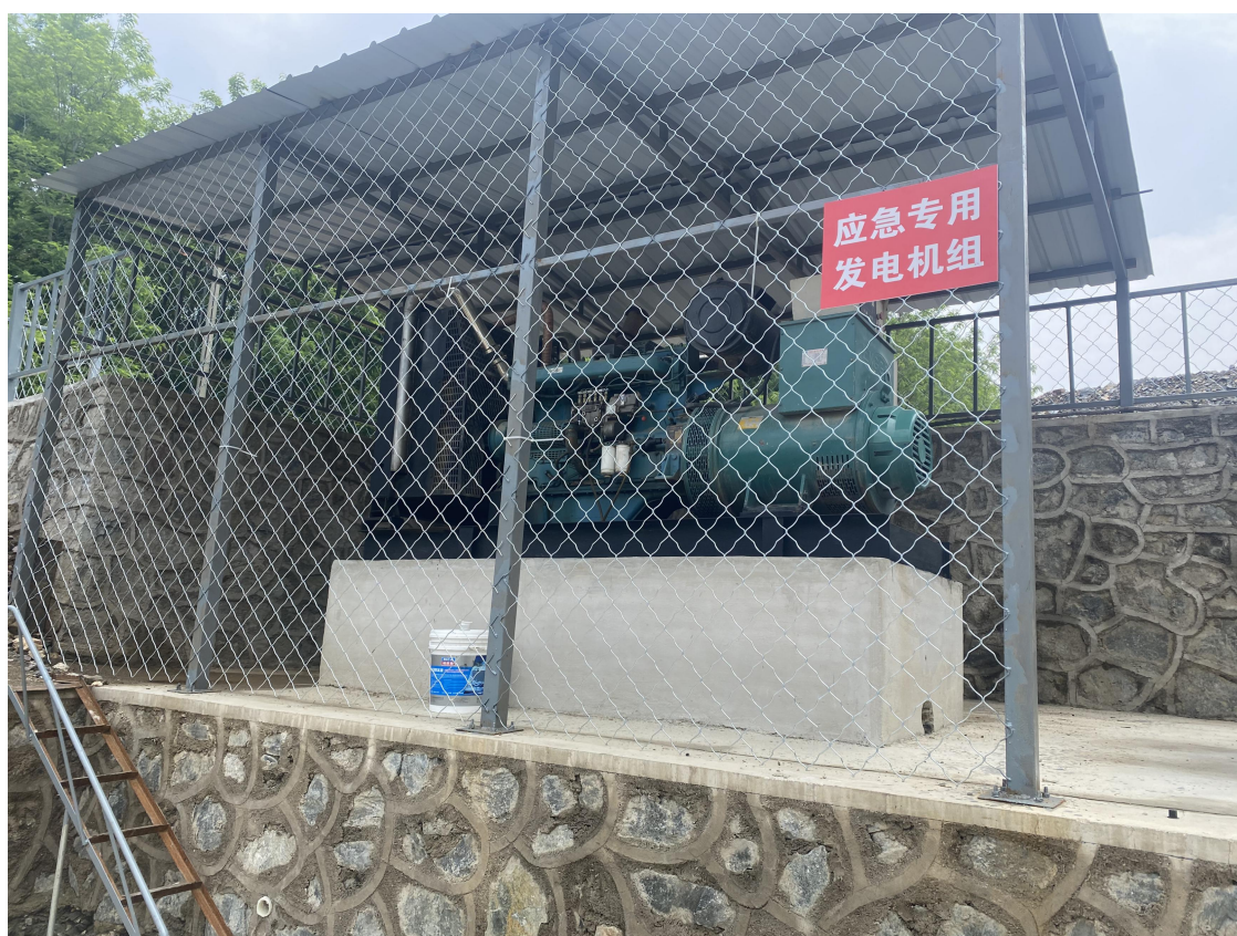
图 2-19 应急柴油发电机
