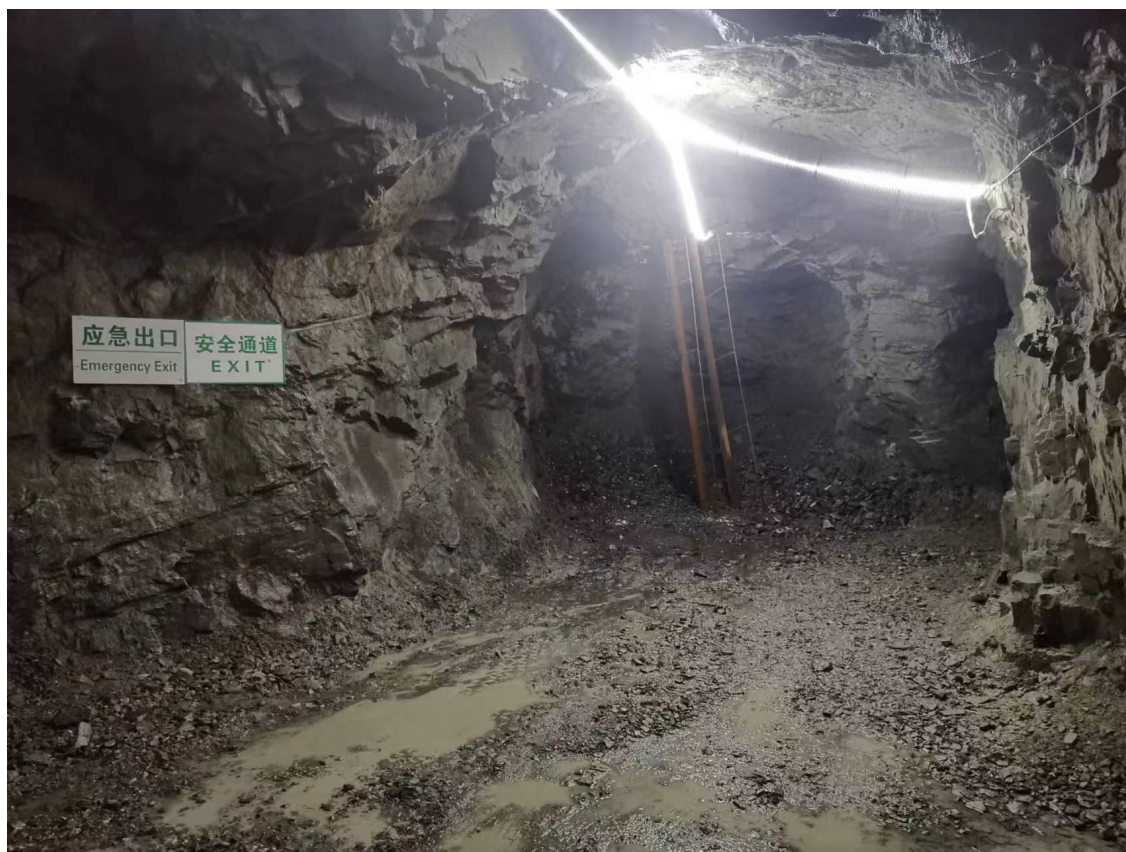
图 2-10 105m 中段回风天井及应急出口
