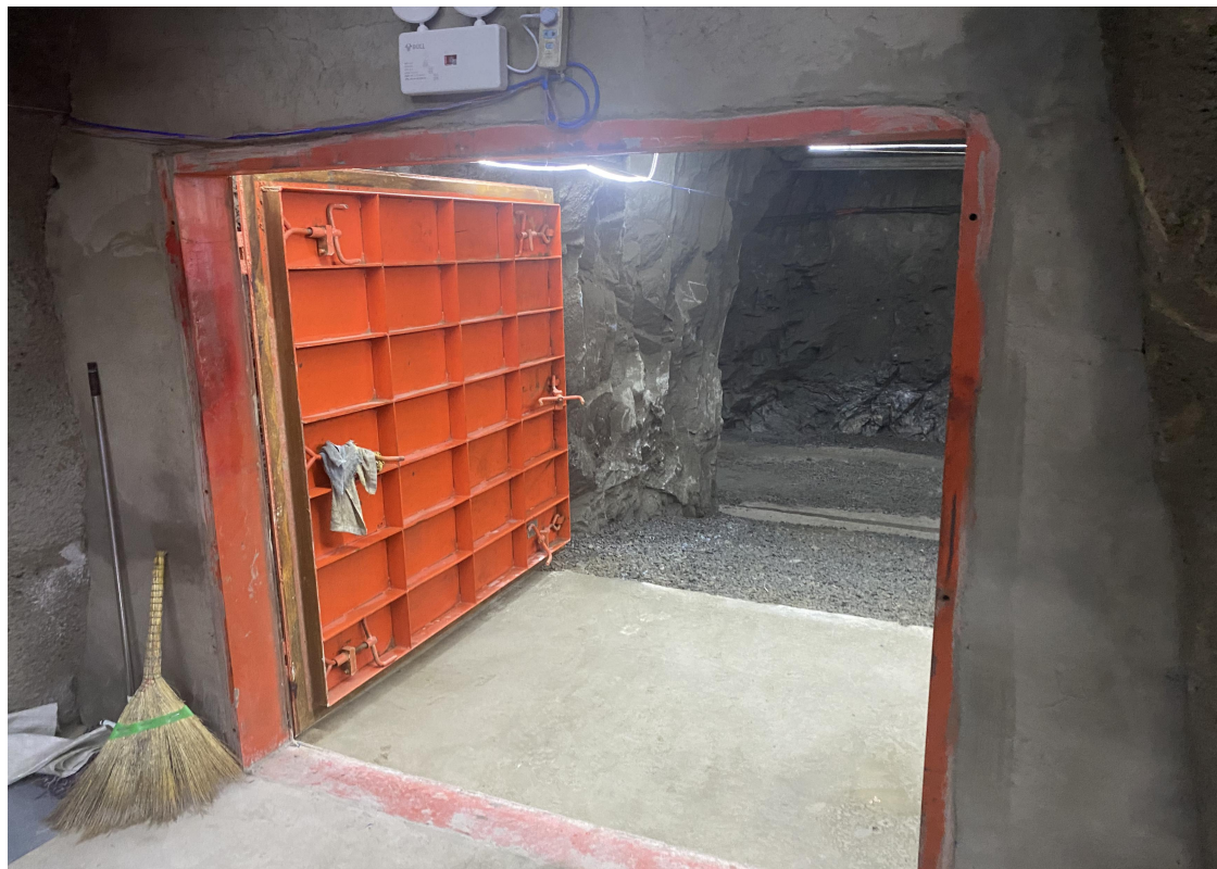
图 2-14 水泵房安全出口
