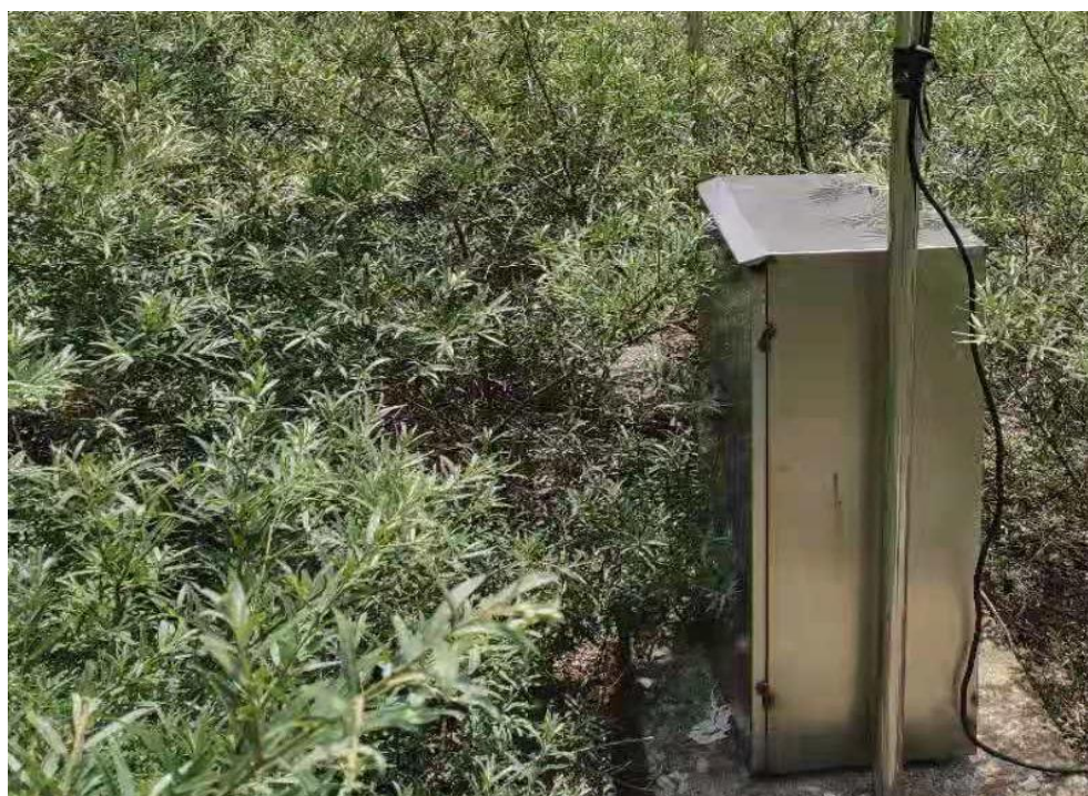
图 2-8 尾矿库监测系统
