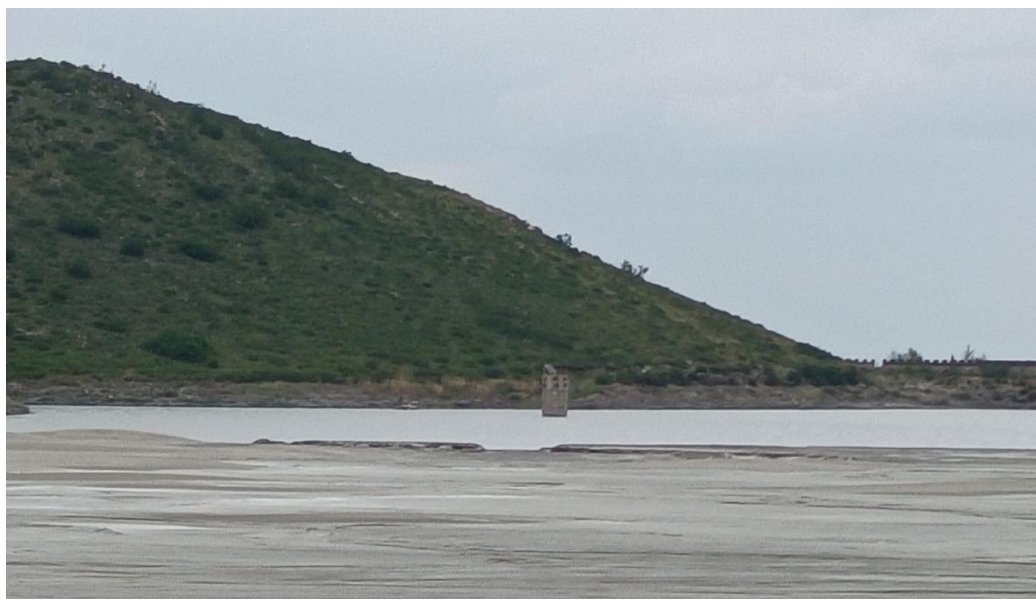
图 2-5 6#溢流井（正在使用）
