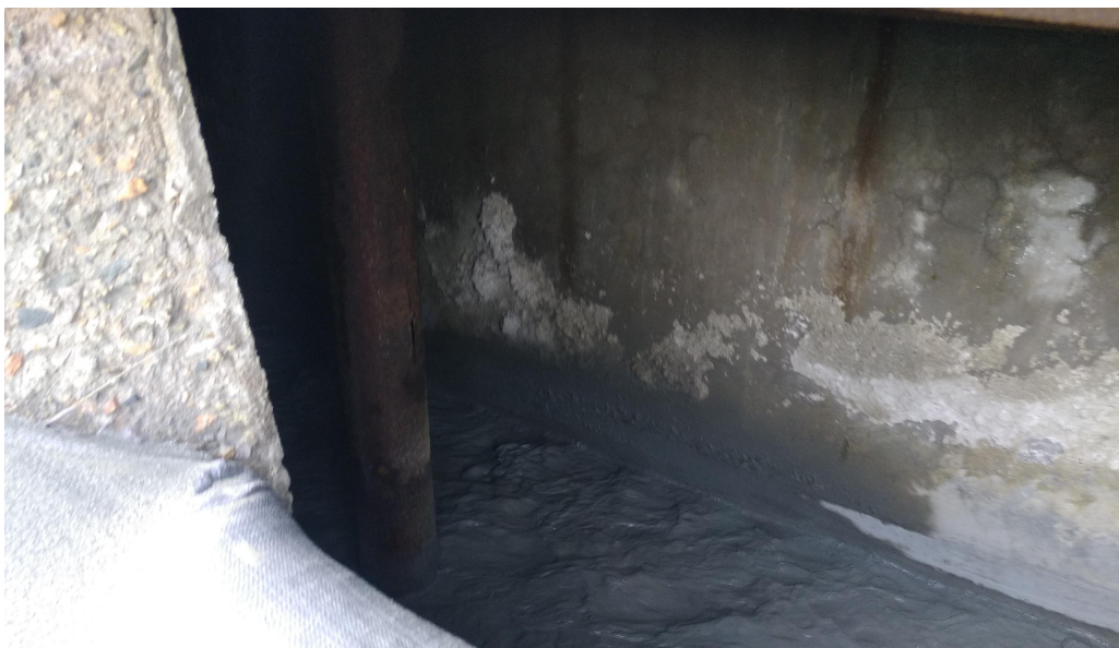
图 2-4 一期尾矿库排水隧洞
