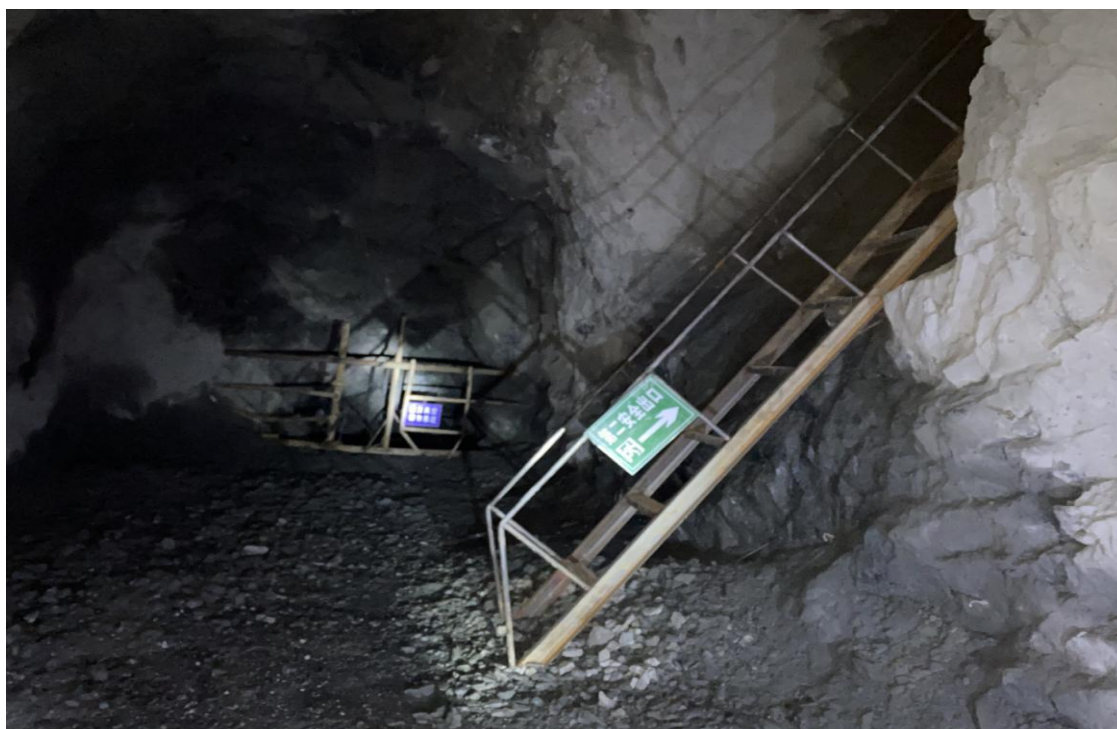
图 2-4 新建风井 FJ 及应急安全出口
