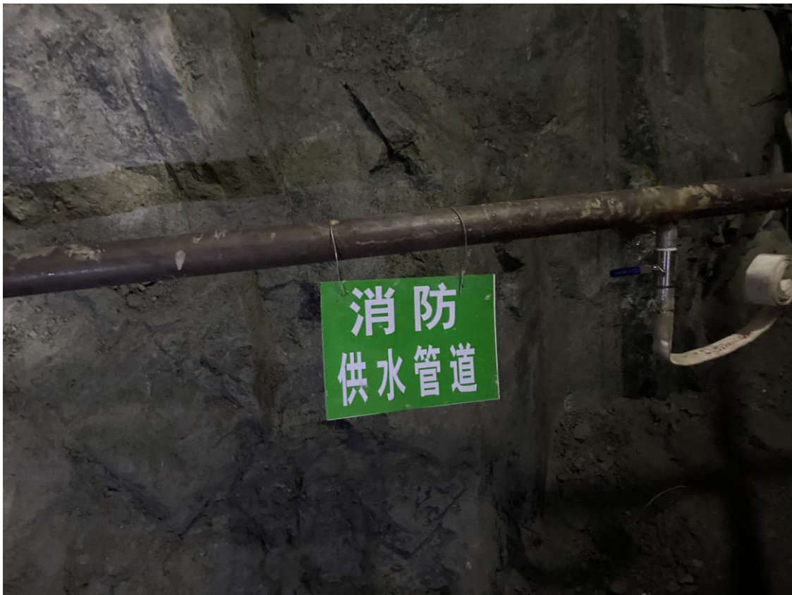
图 2-9 消防供水管路及消防支管和水带
