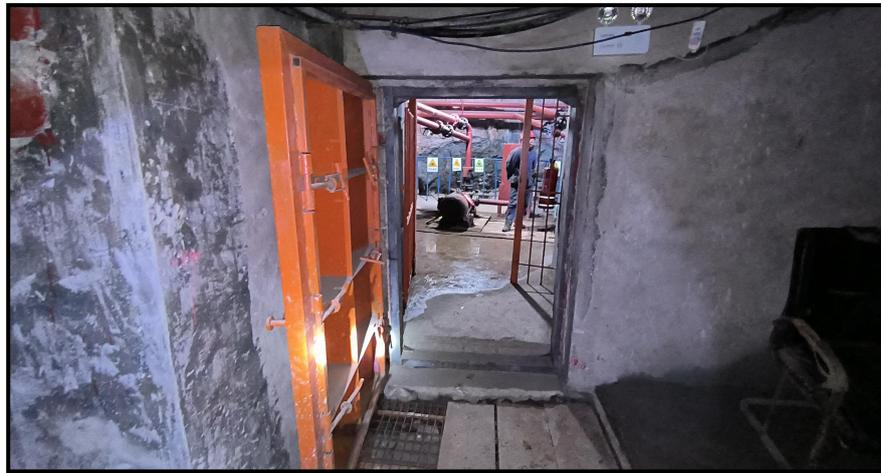
图 2-16 [REDACTED] 中段水泵站防水门
