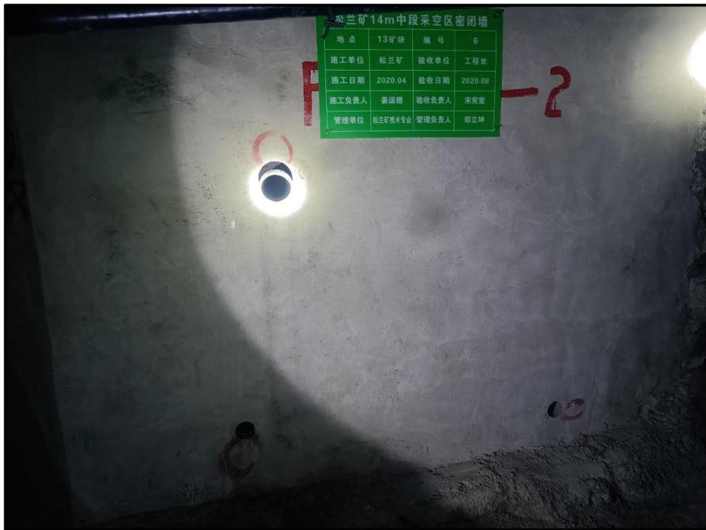
图 2-4 松兰矿采空区封闭墙照片 2
