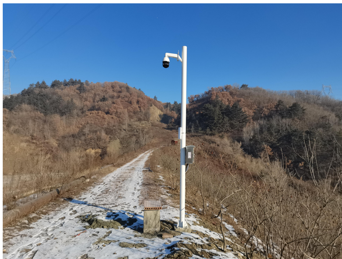
图 2-11 安全监测设施现场安装图
