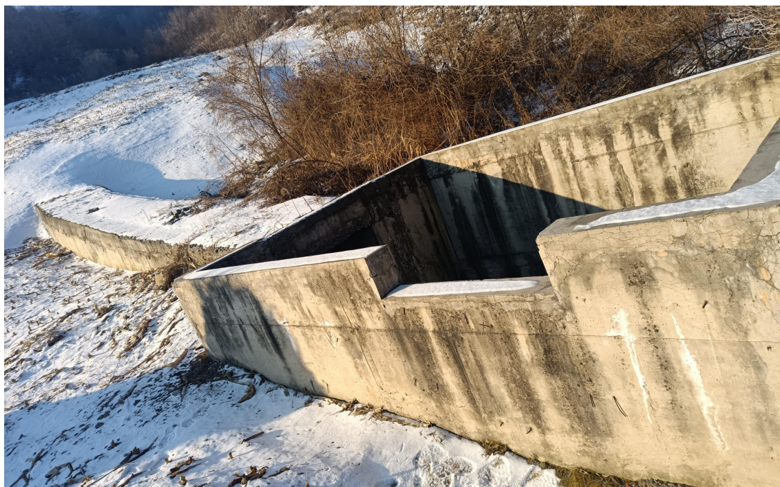
图 2-7 排水斜槽出水口及消力池
