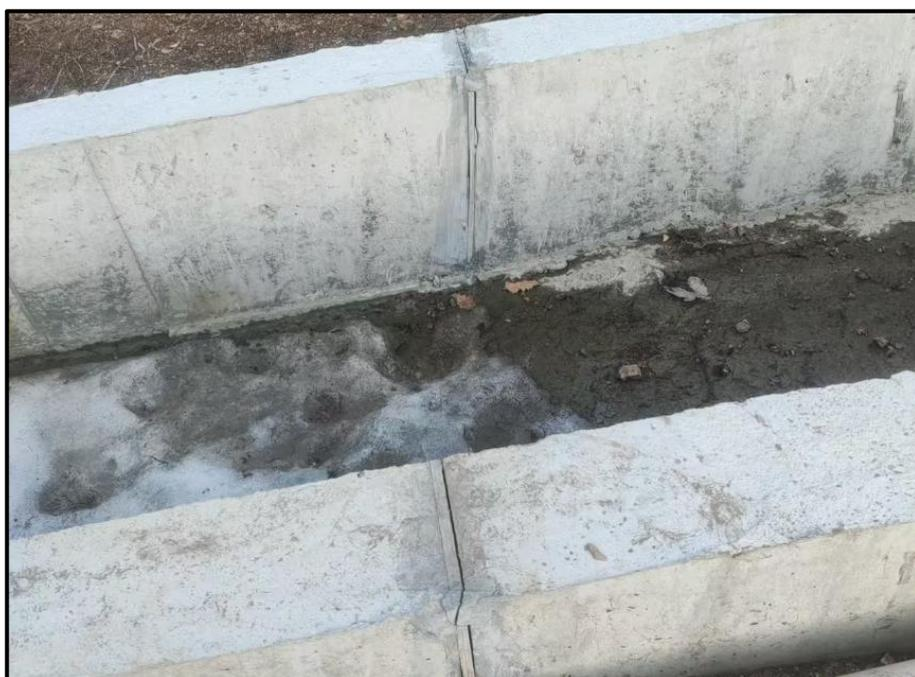
图 2-14 排水明渠伸缩缝现场照片
