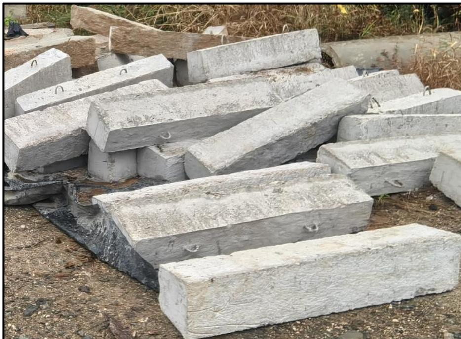
图 2-11 排水斜槽盖板
