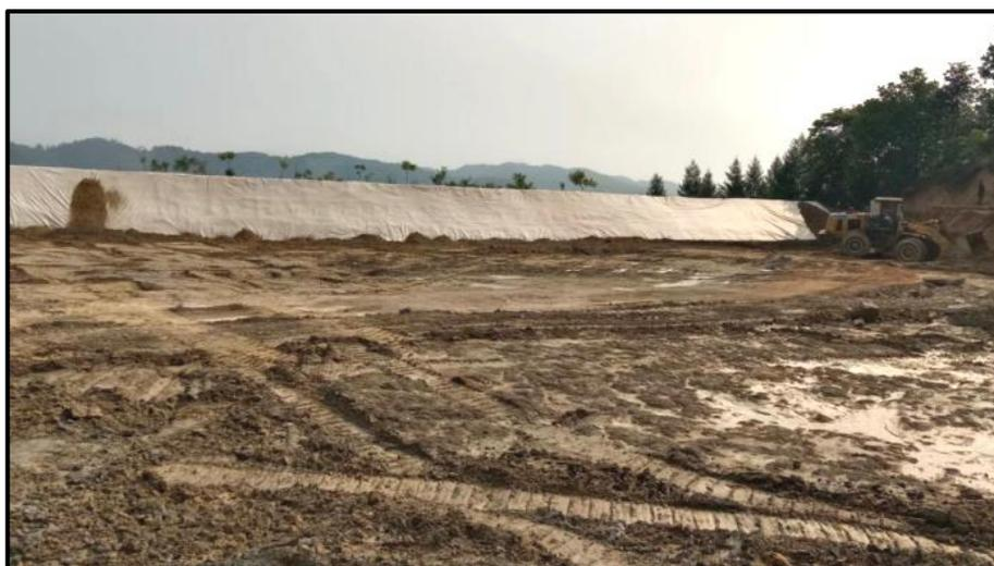
图 2-9 《竣工报告》中堆积坝内坡铺土工膜施工照片
