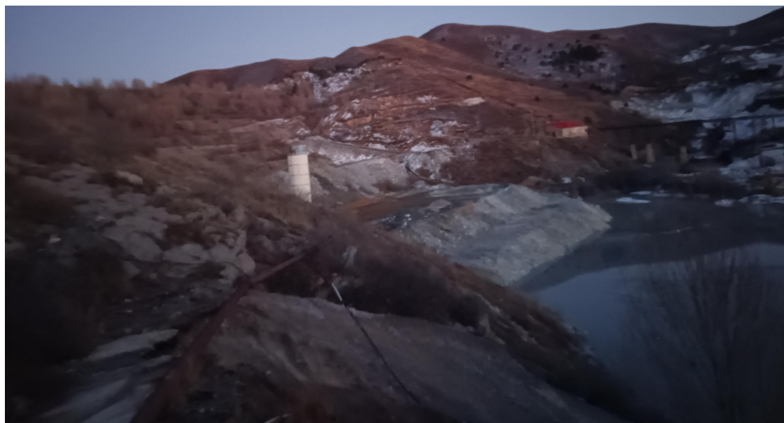
图 2-4 一期尾矿坝压坡工程现状图
