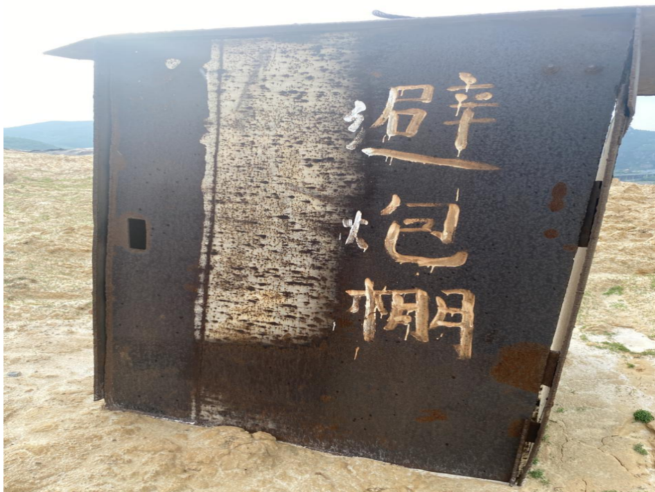
图 2-7 矿界南侧避炮棚
