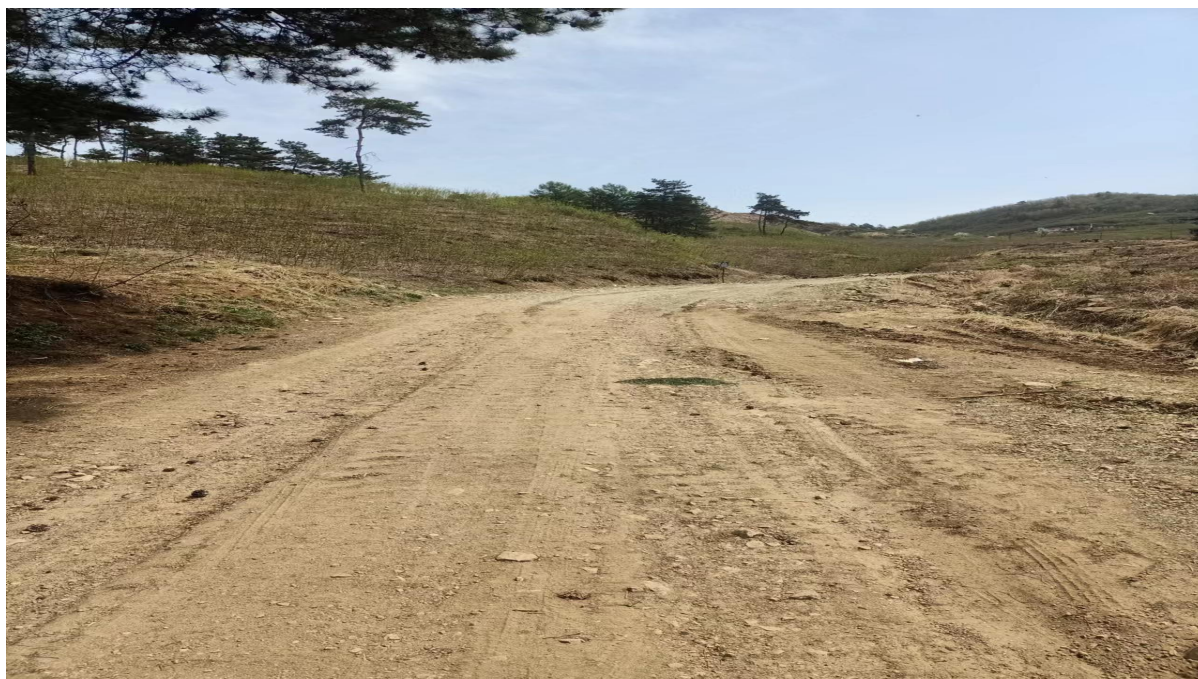
图 2-9 露天采场上矿道路
