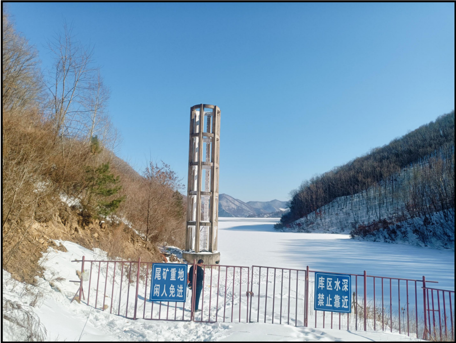
图 2-14 7#溢流井（未投入使用）
