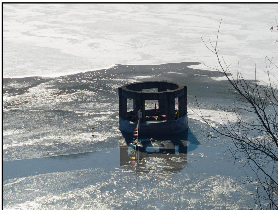
图 2-12 5#溢流井（已封堵）
