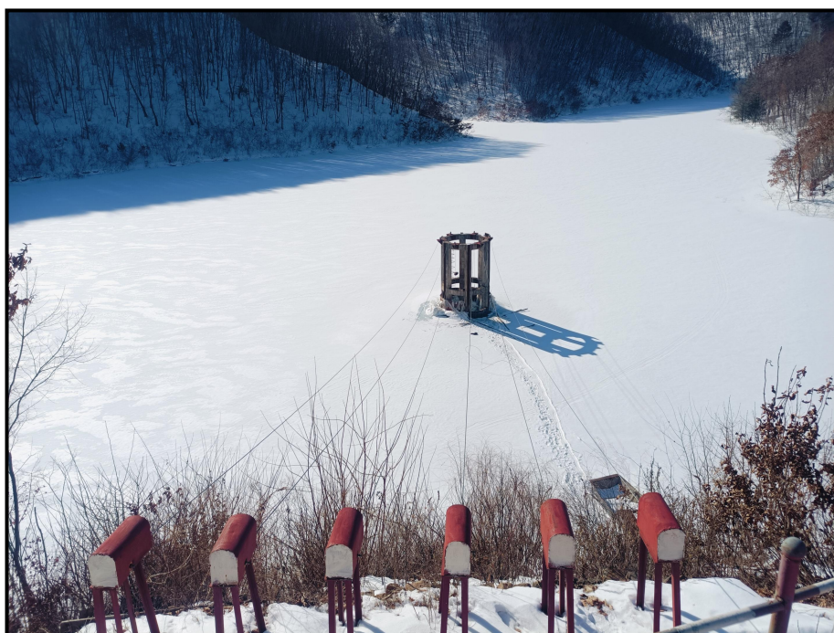
图 2-13 6#溢流井（正在使用）
